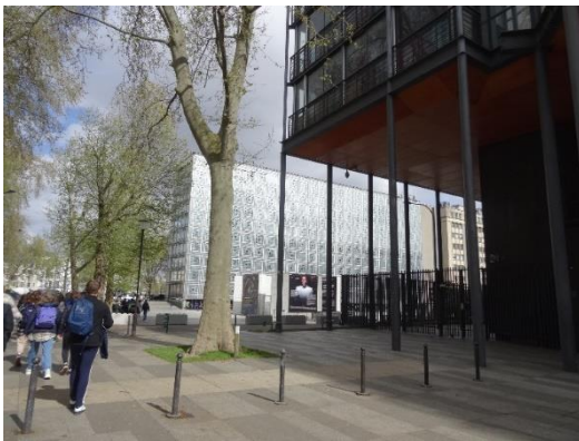
Façade à moucharabiehs
